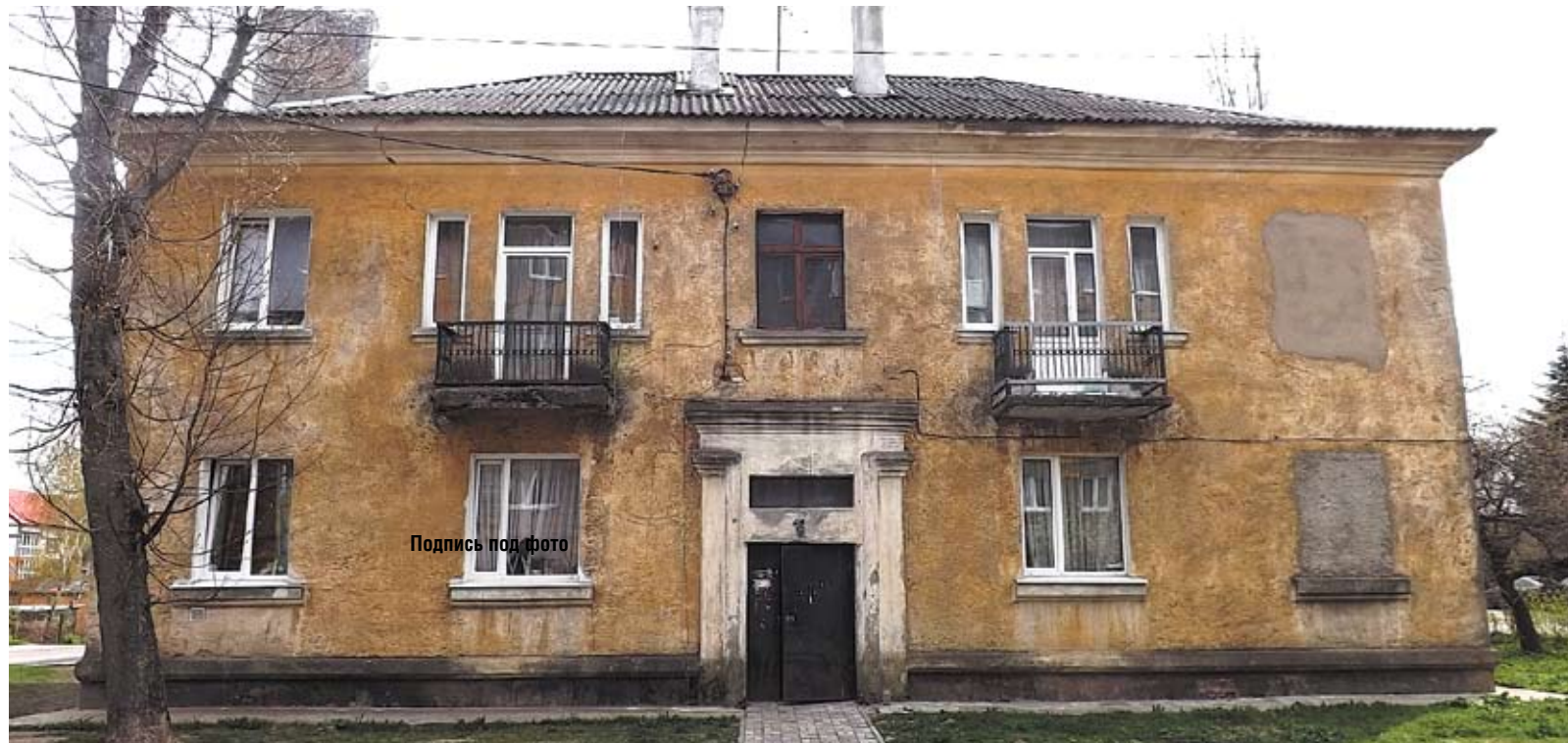
Капитальный ремонт этого дома на ул. Флотской, 1, в Пионерском по новой региональной программе начнется уже в 2016 году
